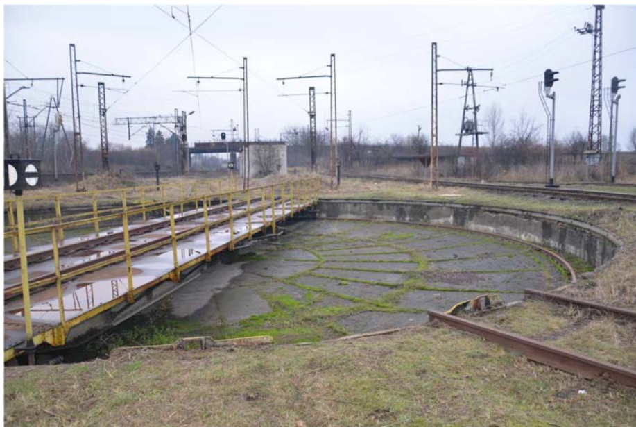
[ FOT 8 ] Teren kolejowy - obrotnica
